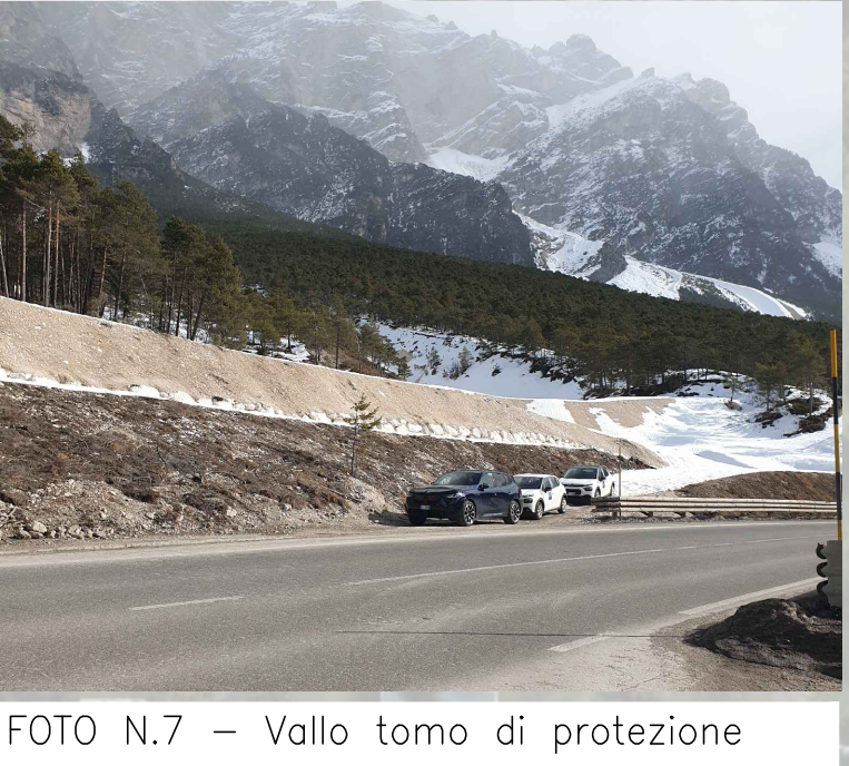
FOTO N.7 – Vallo torno di protezione
